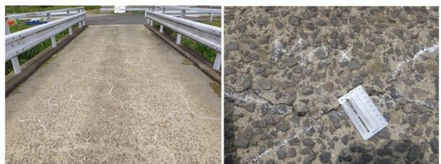
写真-2 施工前の橋面の状況
